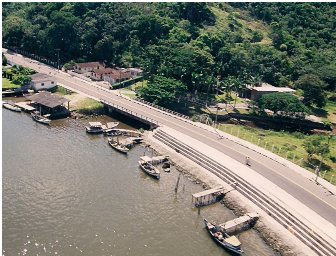
PONTE SOBRE O RIO DAS OSTRAS NA RUA MANOEL REBELO DO SANTOS / 2000
