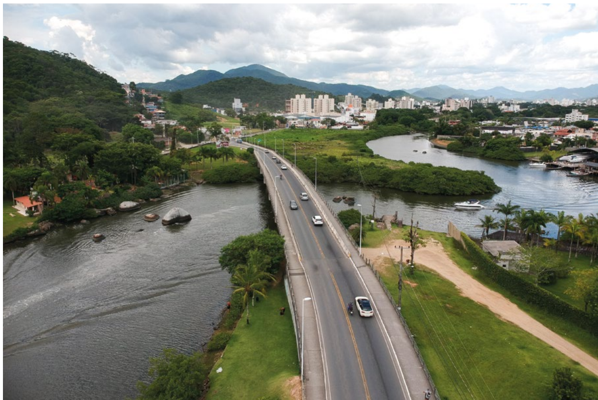
VISTA DA PONTE ALTAMIRO DOMINGOS CASTILHO SOBRE O RIO CAMBORIÚ / 2021
