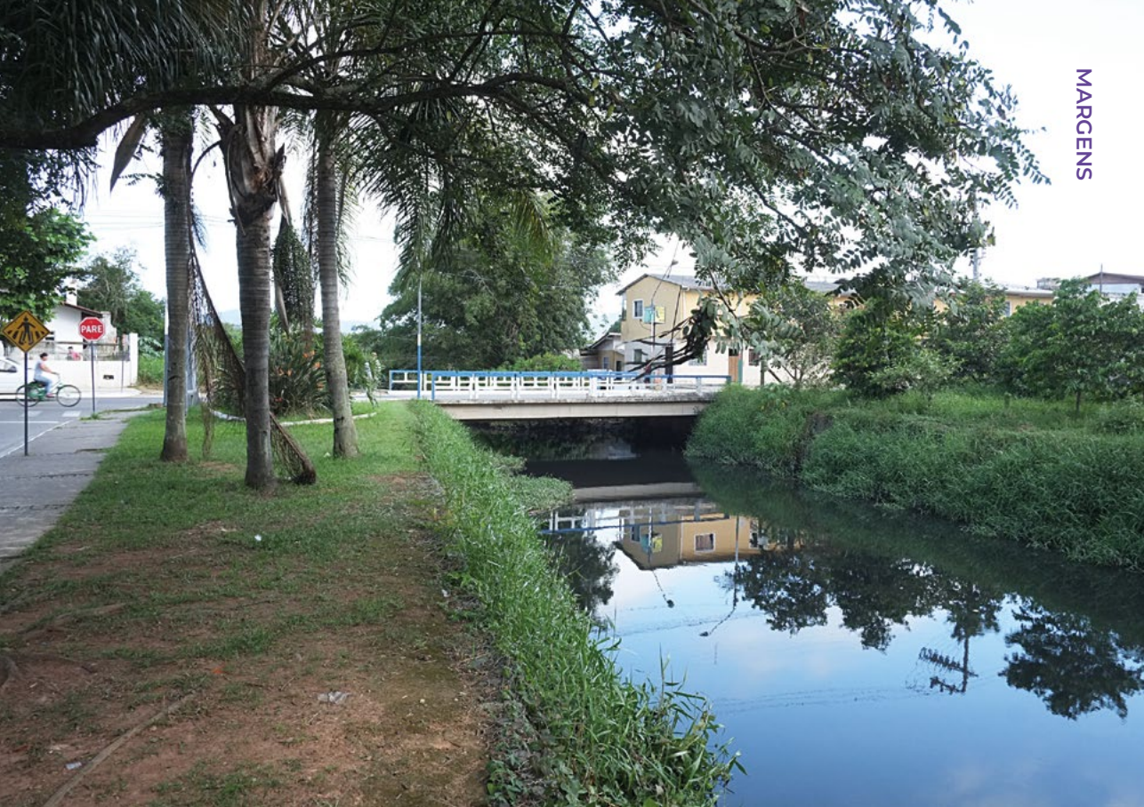
PONTE SOBRE O RIO PEROBA NA RUA BIGUAÇU / 2018
