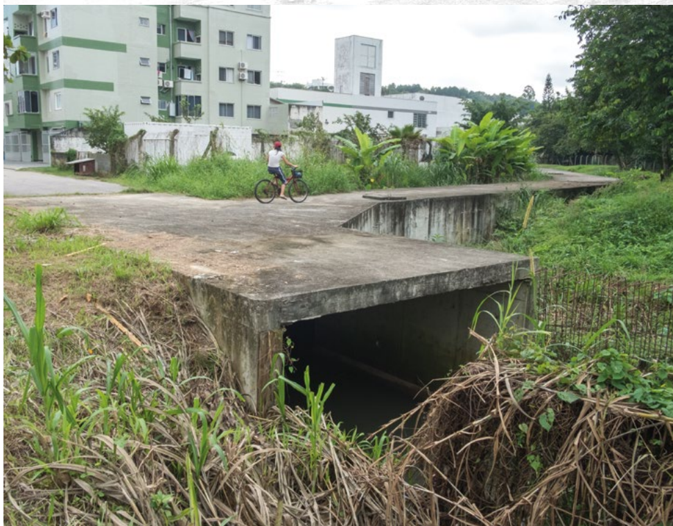
FOZ DO RIBEIRÃO DO NIM / DÉCADA DE 1950 RIBEIRÃO DO NIM CANALIZADO / 2017
